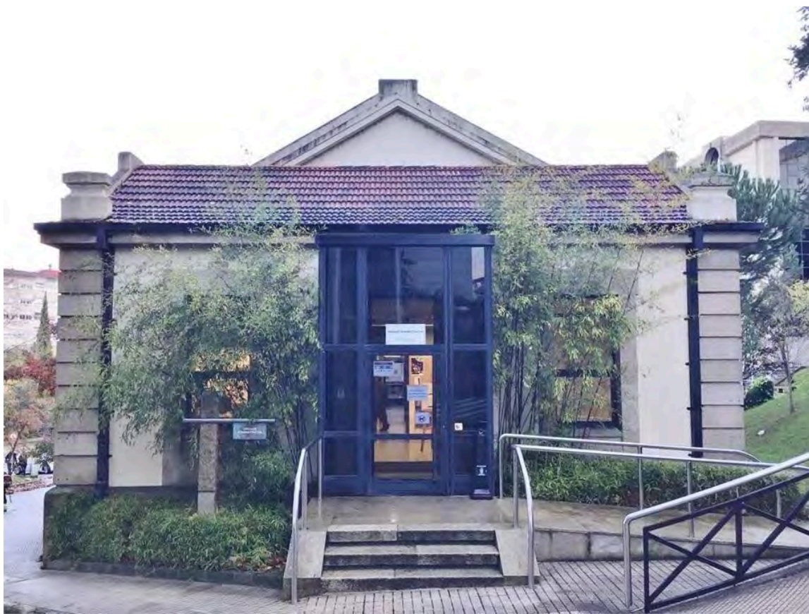
Edificio da Unidade Administrativa
