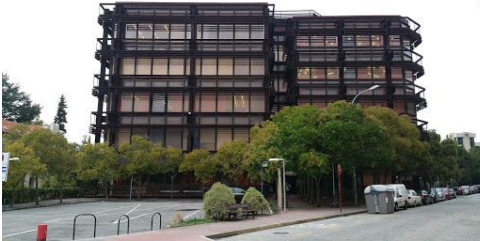
Figura 1. O Edificio de Ferro alberga as aulas onde se imparten os títulos do Centro
